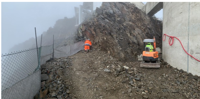
Déroctage au niveau du Télescope Bernard Lyot ©UT3 – K. Aramendy
