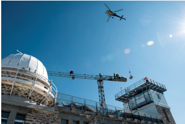
Hélicoptage des contrepoids de la grue ©UT3/OMP - S. Chastanet
